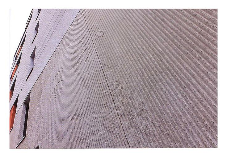
die Schalung gelegt oder geklebt wurden, können sie mit Beton übergossen werden. Sobald dieser ausgehärtet ist, lässt sich die Matrize entfernen und das Relief wird sichtbar. werksplanungsgesellschaft, dass die beiden 6,72 x 5,06 m großen Porträts je nach Fassadenseite auf drei beziehungsweise vier Plattenelemente aufgeteilt und fugenlos an der Fassade befestigt werden.
